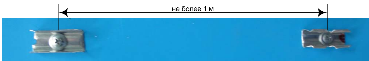
Рис. 20. Применение полупрофильного кабель-канала (верх).
