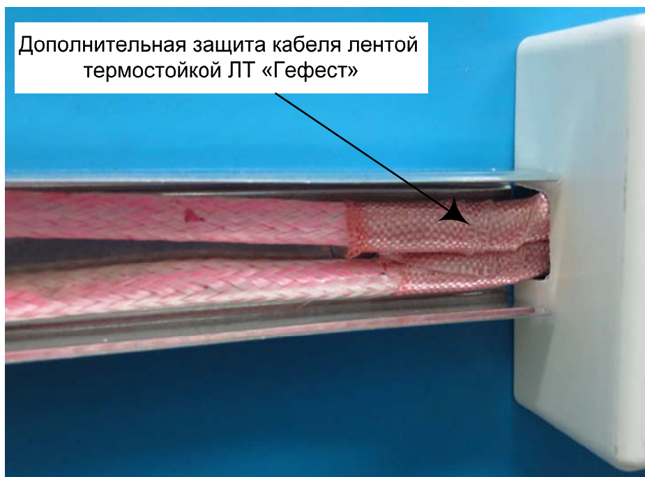
Рис. 22. Пример установки КМ-О с примыканием кабельного канала.
