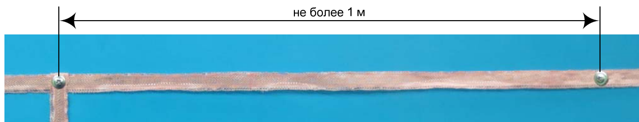
Рис. 13. Прокладка ленты основания.
